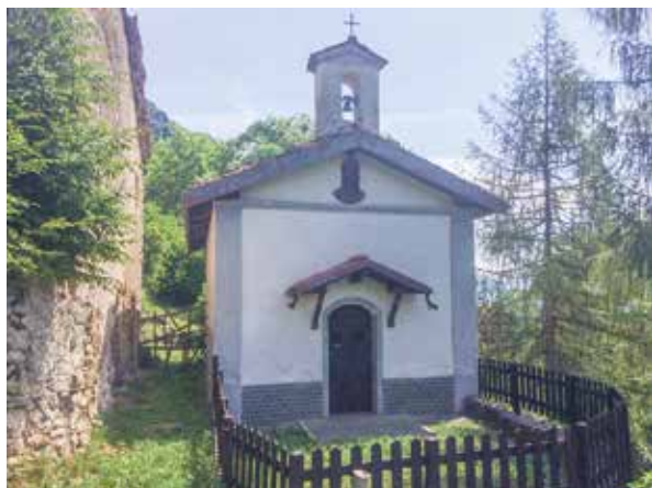
Chiesetta di Cantiglio
